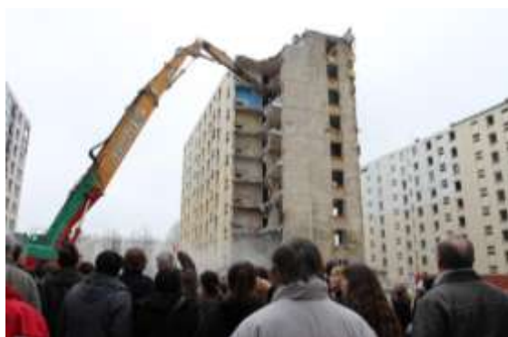
Démolition à Elbeuf-sur-Seine Source : Mairie d'Elbeuf-sur-Seine
